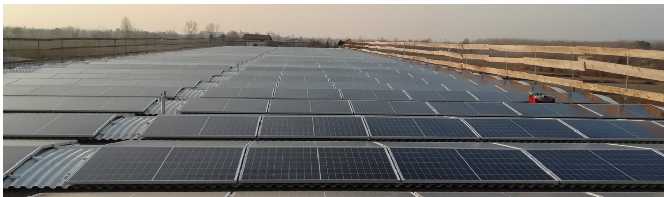
Installazione impianto fotovoltaico
